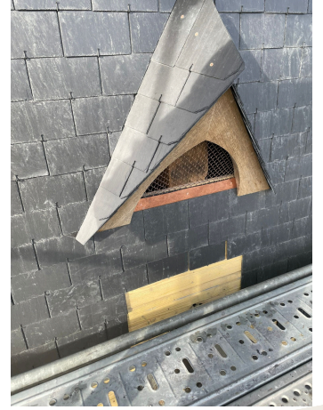
Ouverture de toiture permettant l'aération naturelle de l'église
