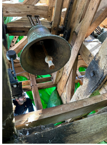
Détail de la cloche et de son mécanisme
