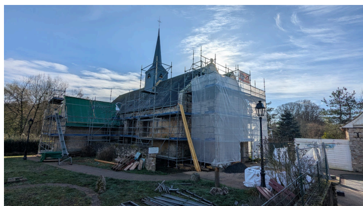
L'église enveloppée attend patiemment la fin des travaux
